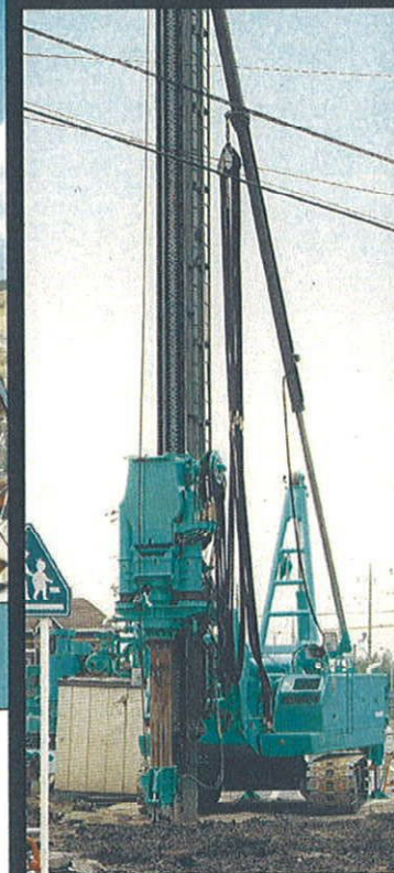
シート圧入作業
