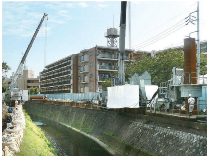
ジャイロプレス工法<sup>®</sup>による住宅地での河川護岸整備工事
