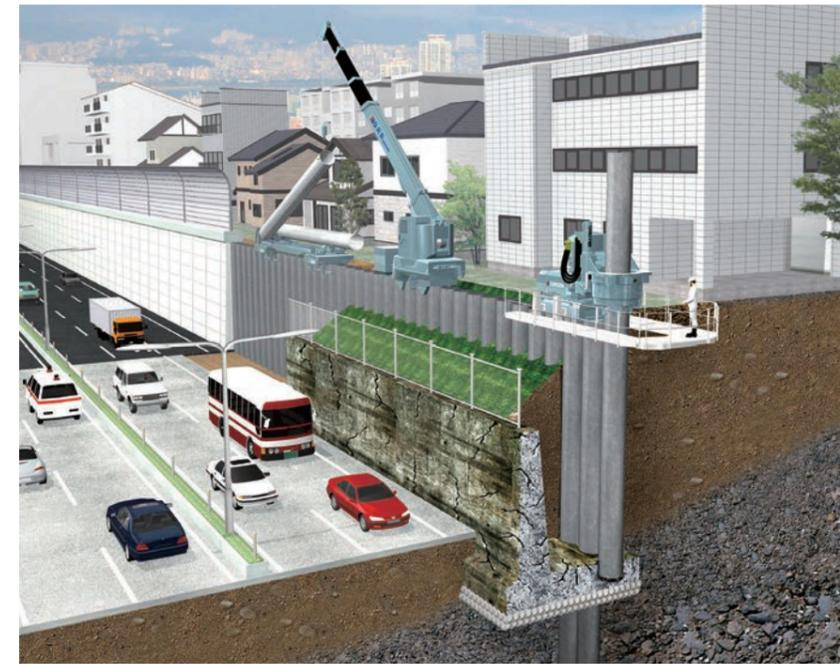
鋼管杭を壁状に連続的に施工し、杭間に杭間部材を挿入することにより、擁壁構造が容易に構築できます。鋼管杭上をクランプクレーンなど各種施工機械が自走するGRBシステム施工によって、都市部の狭隘な場所でも、現況交通や周辺環境に影響を与えず都市機能を進化させることができます。
