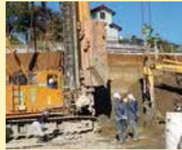
地盤改良工事に
